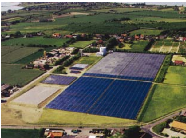
Ilustracija 2 Pogled na solarne kolektore u Riseu
