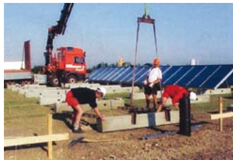
Ilustracija 3 Izvođenje radova na postavljanju novih kolektora u Marstalu
