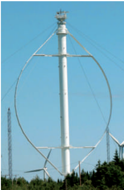
Ilustracija 4 Vjetroturbina s okomitim vratilom (Darrieusovim rotorom) visine 110 m i snage 4 MW u Kanadi
