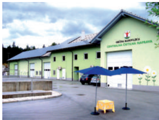
Ilustracija 3 Pogled na zgradu Središnjeg uređaja za pročišćavanje otpadnih voda u Radovljici s FN modulima na krovu
