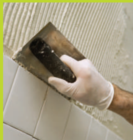
I postavljanje keramičkih pločica valja provoditi po tehničkim propisima
